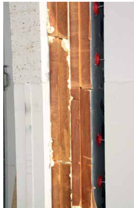
De buitenspouwbladen van dit passiefhuis in Tilburg zijn geïsoleerd met 200 mm dikke Kingspan Kooltherm K8 spouwplaten van Resol-hardschuim met een \lambda -waarde van 0,021 \text{ W/m.K} . De Rc-waarde van de gevel is hiermee 9,5 \text{ m}^2\text{K/W} .
