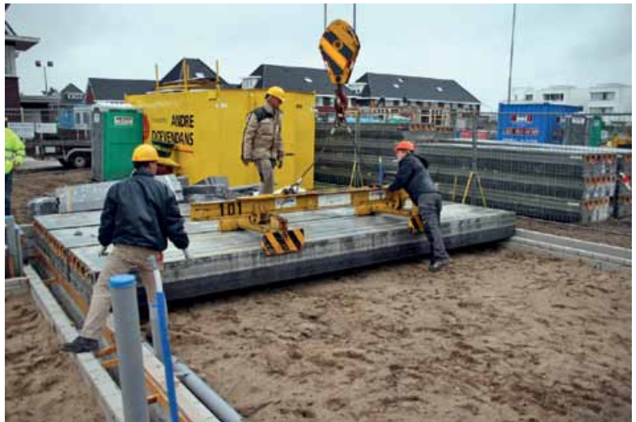
Ribbenvloer van Dycore met 'grijs' EPS en een R_c -waarde van 6,5 m^2K/W . Deze vloer is ook leverbaar met een R_c -waarde van 8,0 m^2K/W en 10,0 m^2K/W .
